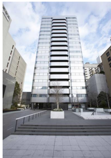
横浜STビル外観
