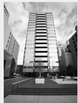
横浜STビル外観
