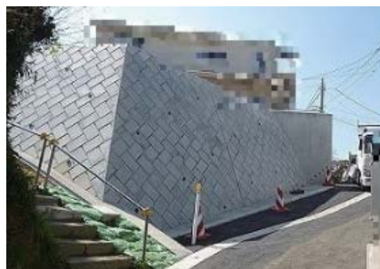
改善後(間知ブロック石積擁壁)
