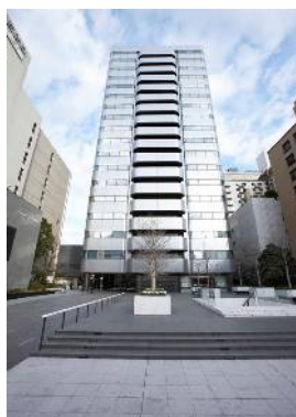
横浜STビル外観
